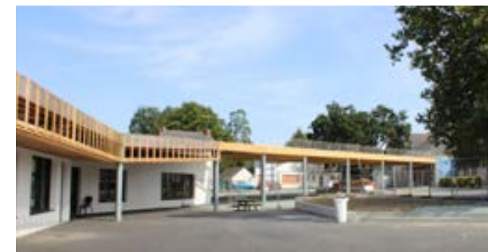
Le nouveau préau sera opérationnel après les vacances de la Toussaint
